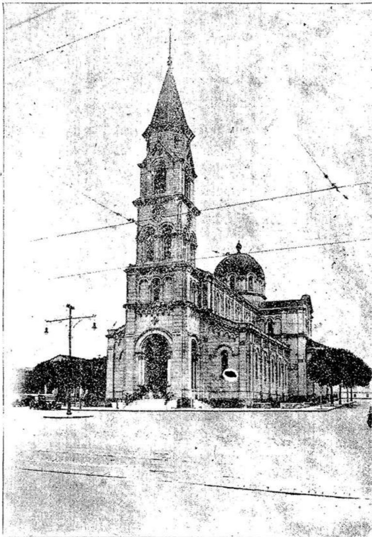
A matriz de Sta. Cecilia, cuja construção iniciada pelo P. Duarte, continuada por seus successores, foi terminada durante o episcopado de D. Duarte, e Sagrada por S. Excia. Revma.
