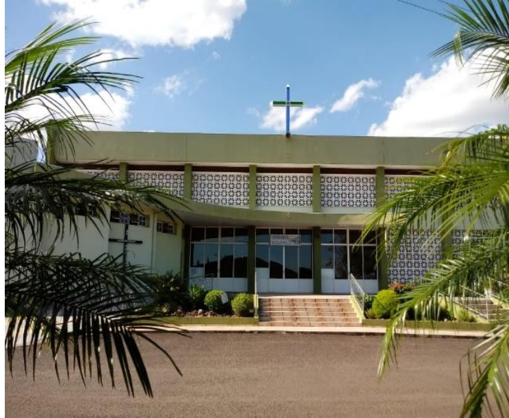
Imagem 07: Identificação dos vitrais na Fachada Frontal
