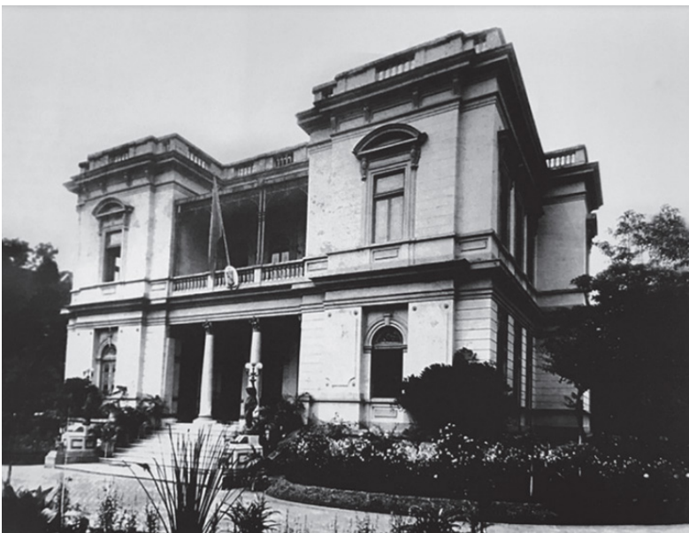
Figura 1.7 Palácio Episcopal ou Palácio São Luis, onde era o antigo o palacete-sede da chácara do Barão de Souza Queiróz (localizado na rua São Luiz nº 02). A residência pouco sofreu alterações em sua fachada, já em estilo neoclássico, a não ser na instalação do brasão da arquidiocese (na entrada principal). Autor: desconhecido. Acervo: Arquivo da Cúria Metropolitana de São Paulo.
