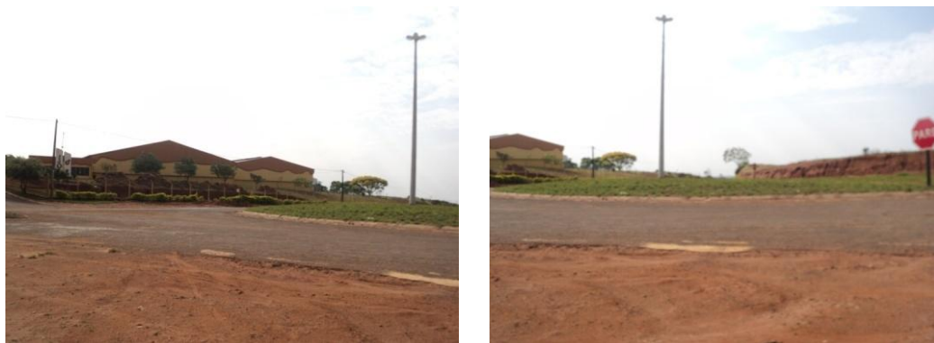
Figura 28 - Acesso ao parque industrial. Fonte: Acervo pessoal
