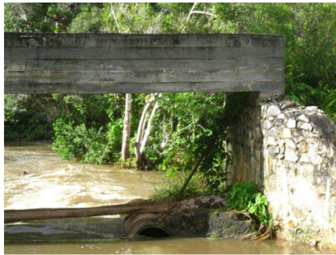
Photo 8 : Le pont de ciment (M.P, juillet 2010)
